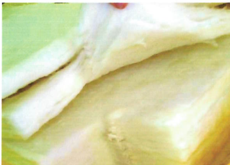
Figura 7 - PLR em bom estado (sem delaminação)
